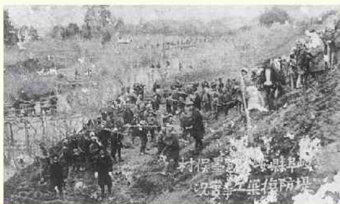
長良川堤防復旧工事の様子
