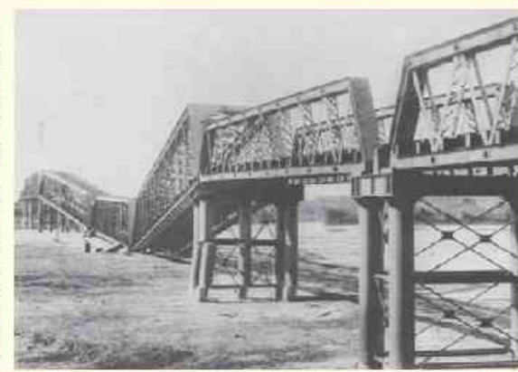
落した長良川鉄橋
