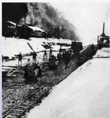
鏡岩の導水路造成工事
