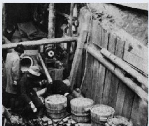
上水道水源地工事
