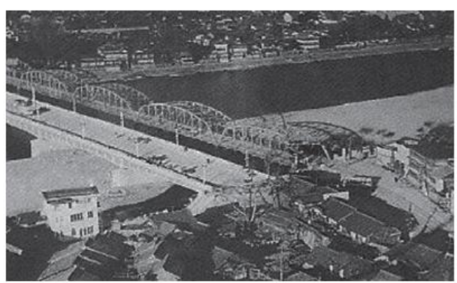
昭和31年・新旧の長良橋(工事中)
