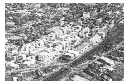
— 岐阜織維卸センター(昭和46年) —
