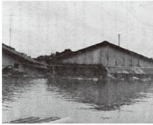
水に浸かった工場(11日)
