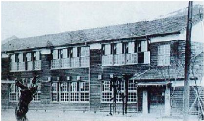
小学校校舎を移築した梅林中学校校舎
