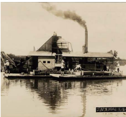
荒田川下流部の浚渫船
