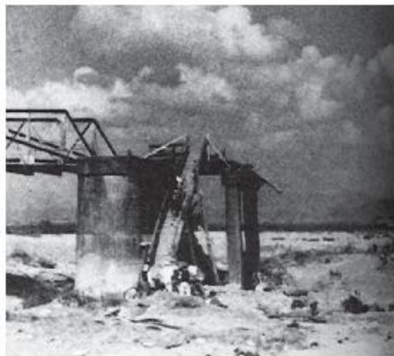
34年9月 藍川橋流失
